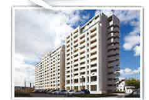
大阪府宮津南別府住宅第2期耐震改修工事 施工：森長・榎並JV 設計者：(株)日建建設事務所 完成日：2013年8月31日 構造・規模：RC、PC造・12F・6042.39㎡
