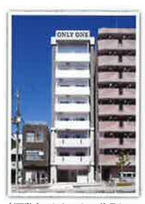
(仮称)クレイン北区本庄東新築工事 設計者：竹田設計事務所 完成日：2013年4月 構造・規模：RC造・8F
