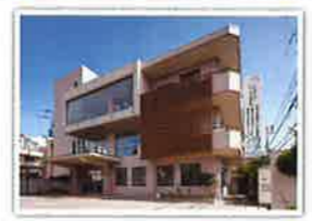
もりぐち在宅サービス供給ステーション改築工事 設計者：中尾総合建築設計事務所 完成日：2013年7月 構造・規模：RC造・3F・773.57㎡
