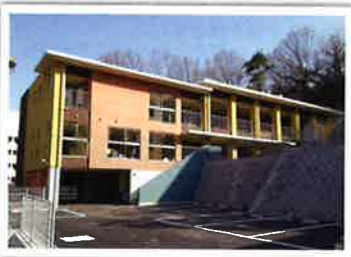
(仮称) ソフィア東生駒保育園新築工事
