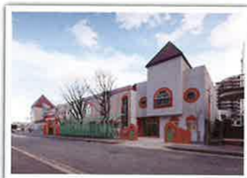
ファミリー保育園フローラ園舎 大規模修繕工事(耐震補強工事を含む) 及び増築工事
