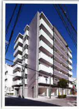
(仮称) 西九条マンション新築工事
