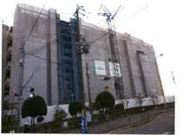
大阪府営摂津南別府住宅 第2期耐震改修工事 設計者：柳日総建大阪事務所 完成予定：2013年8月 構造・規模：RC、PC造・12F・6042.39㎡
