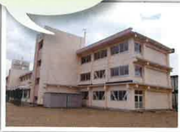
平成23年度 川西市立清和台南小学校 西校舎棟耐震補強等工事
