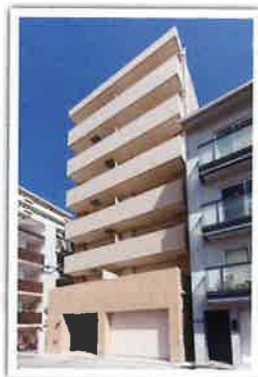
(仮称) 国分寺マンション新築工事
