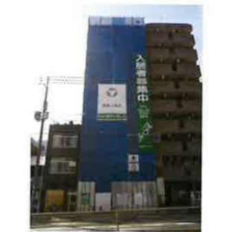
(仮称)クレイン北区本庄東新築工事 設計者：竹田設計事務所 完成予定：2013年4月 構造・規模：RC造・8F
