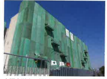
大阪府営守口錦通住宅耐震改修工事 設計者：柳小笠原設計 施工：森長・榎並JV 完成予定：2013年8月 構造・規模：RC造・8F
